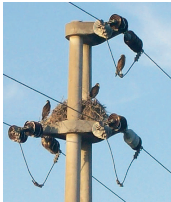
Fotos 5 y 6. Monoposte y poste de retención (biposte) en T4. El tendido de esta transecta se compone de monopostes. En general, cada 6 km se intercalan bipostes de retención, distintos en su estructura, a los bipostes de T1 y T2. En el tipo de monoposte de T4, G. polyosoma no nidifica. Fotos: Eduardo De Lucca.
