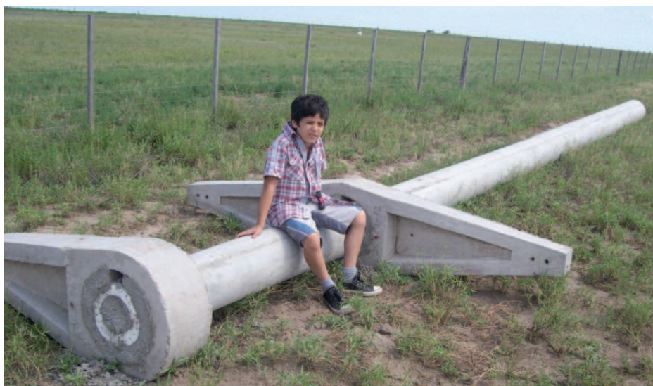
Foto 10. Este poste, a punto de ser instalado, brinda la posibilidad de observar el diseño de las crucetas con sus cavidades. Foto: Eduardo De Lucca.
